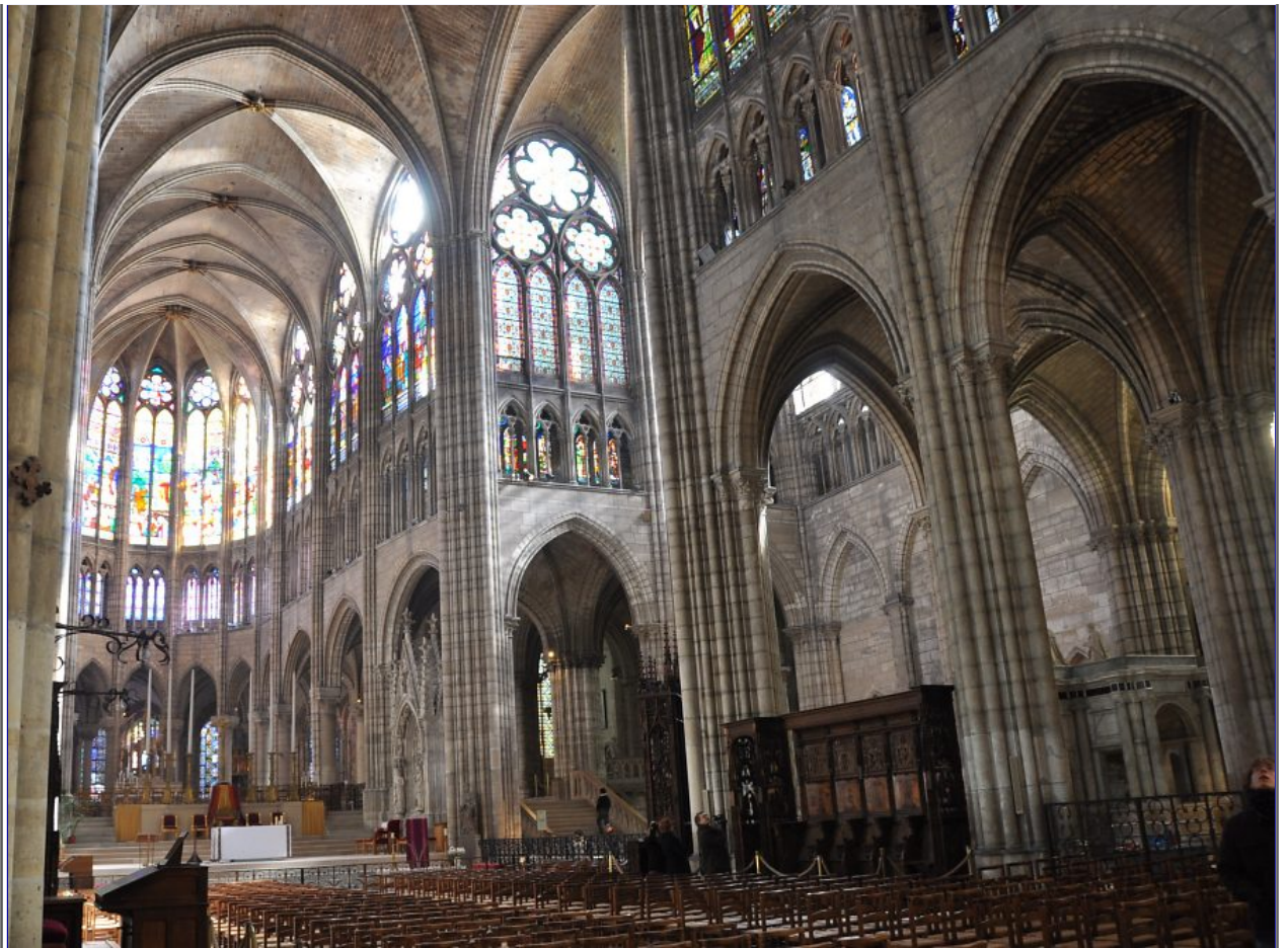
Nef, bras droit du transept et chevet de la basilique Saint-Denis Le triforium de la basilique est totalement ajouré, apportant un maximum de lumière.
