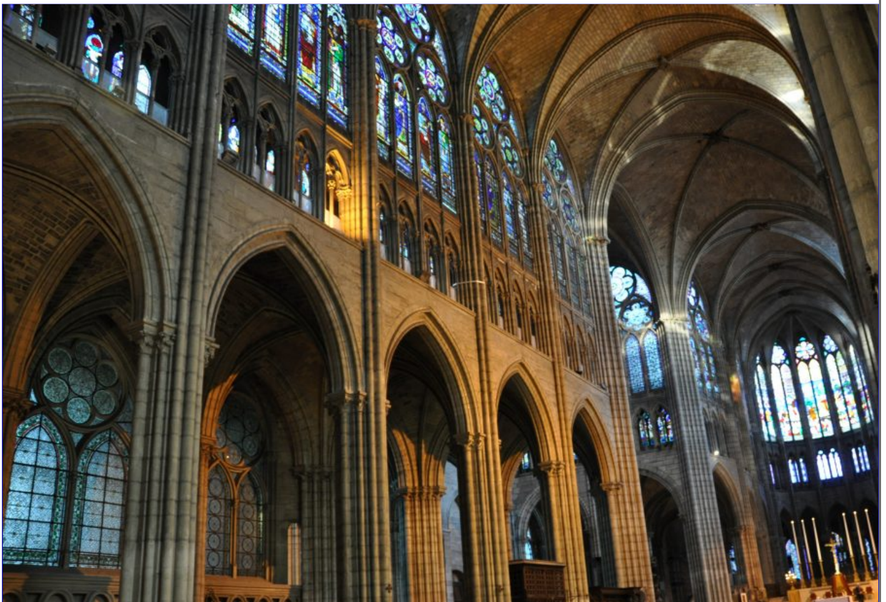
Élévations dans la nef avec le triforium ajouté.
