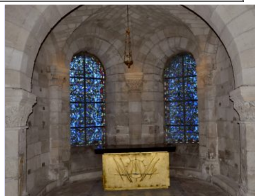
La crypte de Suger Chapelle avec son autel et ses deux vitraux Pour établir l'assise de sa cathédrale, Suger fit construire une crypte bordée de sept chapelles rayonnantes, exactement situées sous les chapelles rayonnantes du déambulatoire au-dessus.
