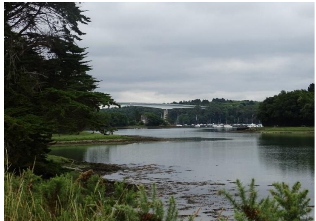
Le pont de Cornouaille au-dessus de l'Odet
