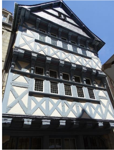
Maison à pans de bois
