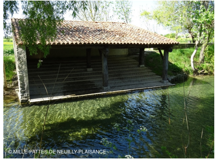
Lavoire à gradins
