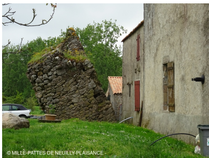
Tour penchée à la Gerbaudière
