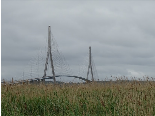
Le pont de Normandie
