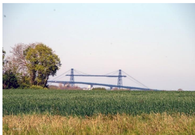
Les 2 ponts de Rochefort
