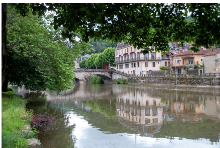
Le pont national
