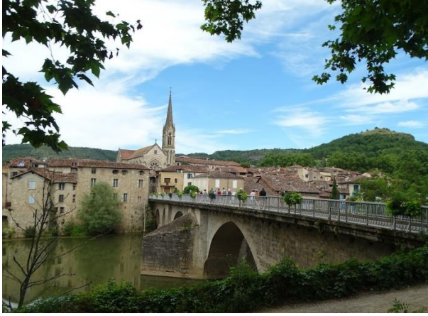
Le pont à l'entrée de Saint Antonin
