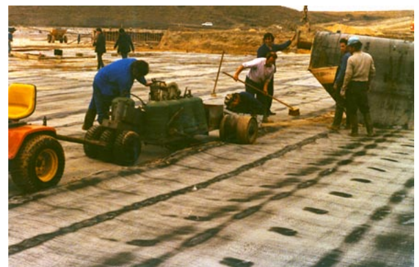
Mise en place de l'étanchéité du grand lac
