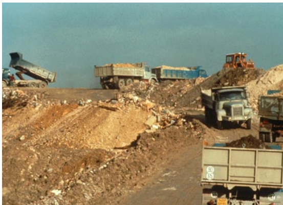
13 millions de m3 de remblais vont être apportés
