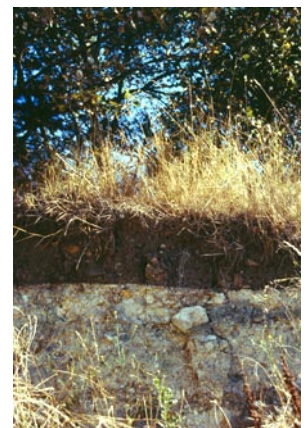
Les remblais compactés sont ensuite couverts de 50 cm de terre végétale
